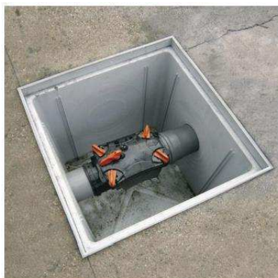
Clapet anti-retour dans un regard visitable
