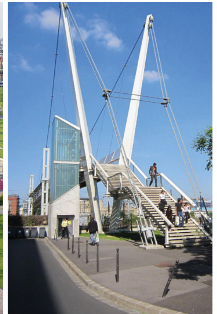
Passerelle Parc des Cormailles, Ivry, agence TER
